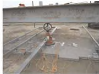
图1 铝道面板承载力现场试验
